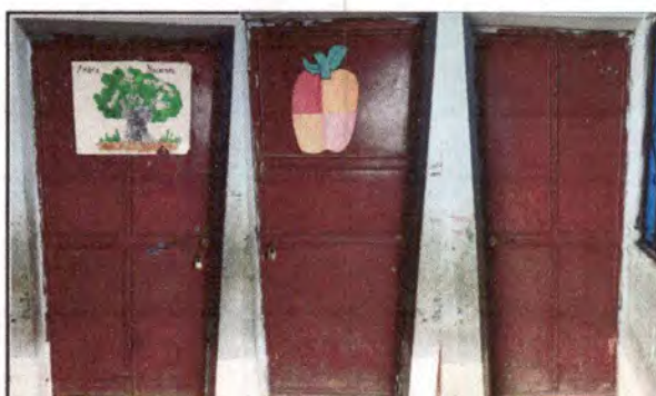
Foto 12: Mantenimiento a estructura de puertas en Aulas (lijado, cambio de tubo, cepillado, sujeciones, aplicación de pintura)
