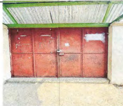
Foto 8: Mantenimiento a portones de metal
