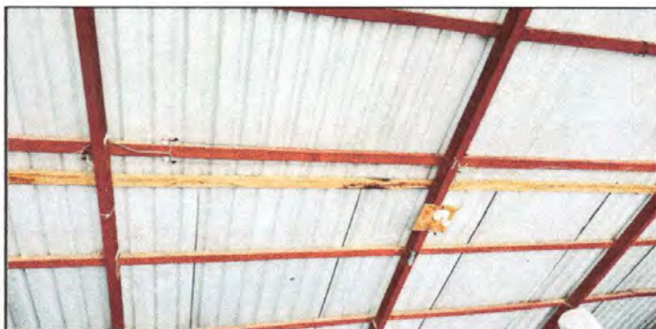
Foto 9: REPARACION DE SISTEMA ELÉCTRICO
