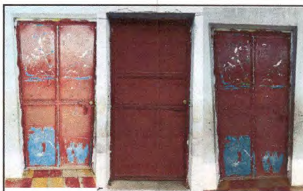
Foto 10: Mantenimiento a estructura de puertas en Aulas (lijado, cambio de tubo, cepillado, sujeciones, aplicación de pintura)
