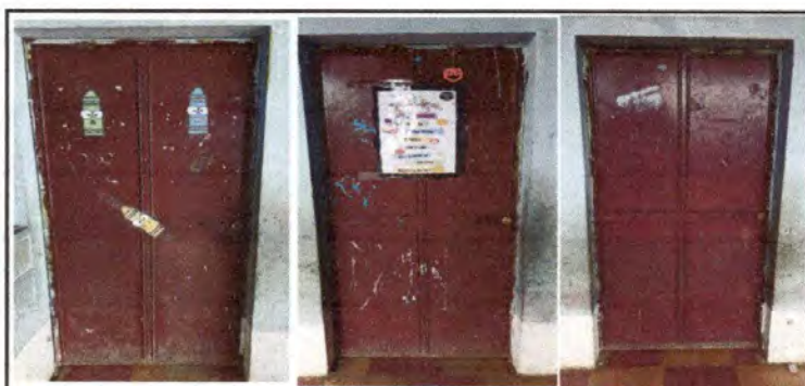
Foto 11: Mantenimiento a estructura de puertas en Aulas (lijado, cambio de tubo, cepillado, sujeciones, aplicación de pintura)
