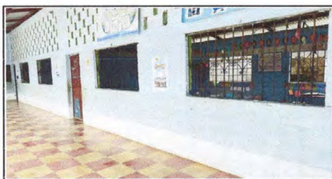
Foto 5: Mantenimiento a balcones de metal
