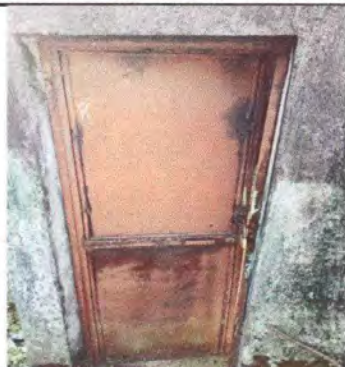
Foto 7: Mantenimiento a estructura de puertas en Baños (lijado, cambio de tubo, cepillado, sujeciones, aplicación de pintura)
