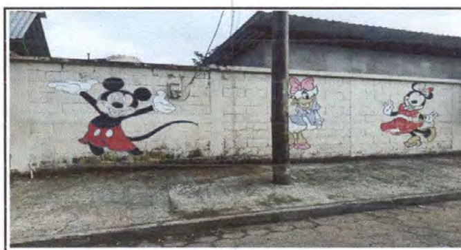
Foto 6: Pintura en muros exteriores e interiores
